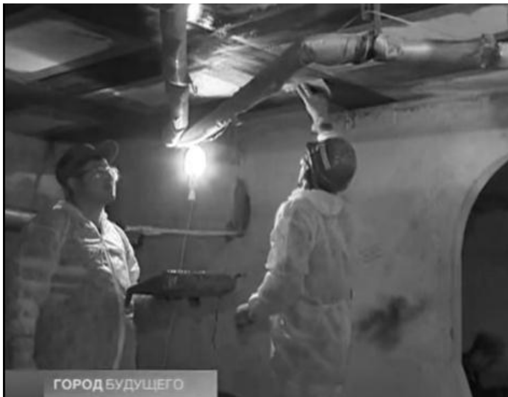
Рис. Е. 1. Використання карбонових матеріалів для укріплення залізобетонних конструкцій ( www.youtube.com/watch?v=tjg7mhssdTM ).
