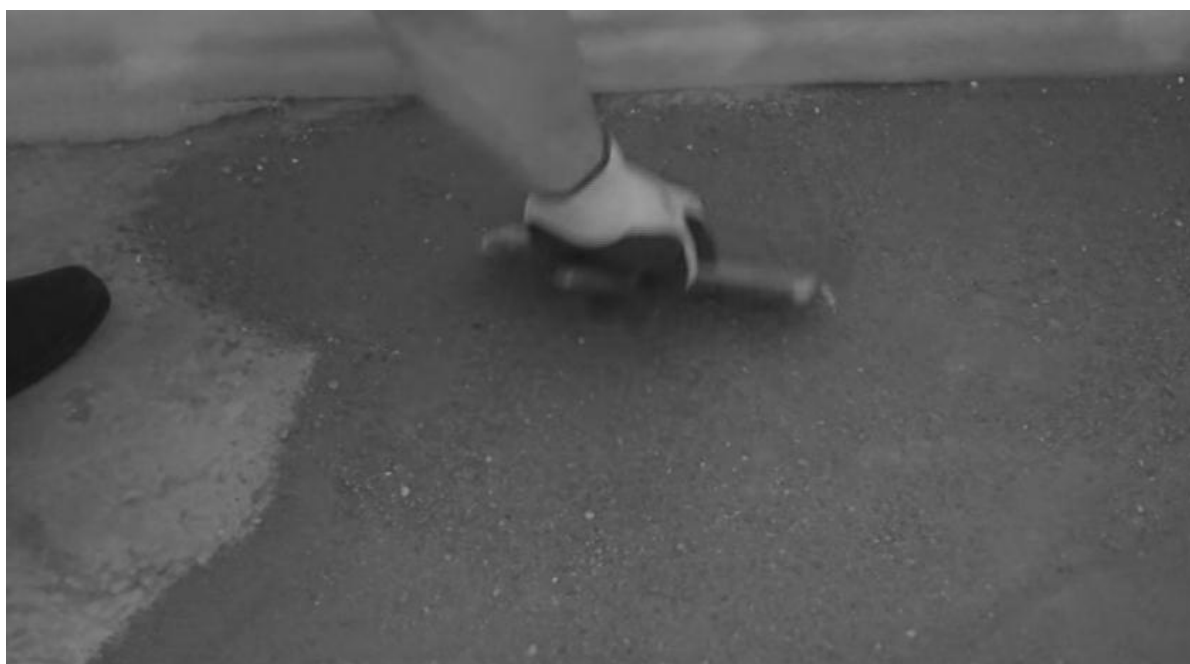
Рис. Е. 2. Підготовки плит перекриття до облаштування підлоги з підігріванням.
