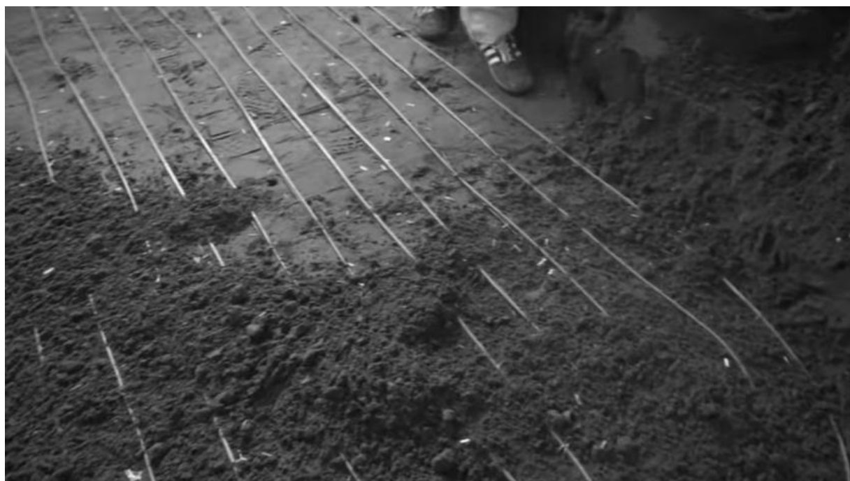
Рис. Е. 8. Засипання пісково-цементної суміші.
