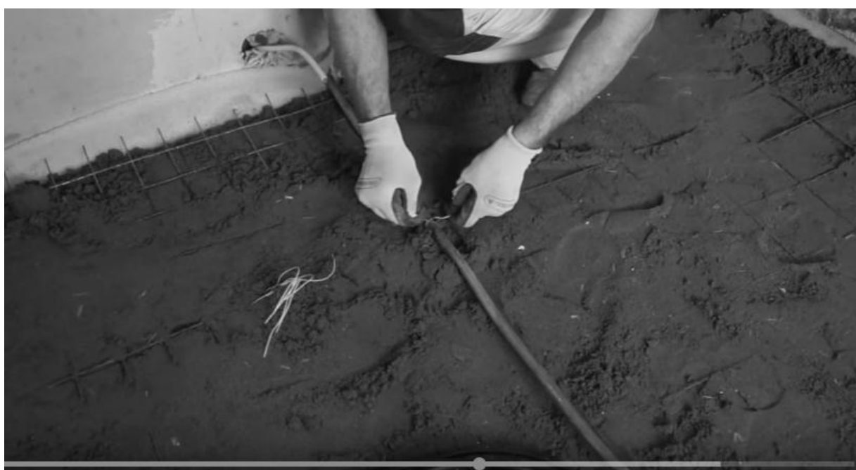
Рис. Е. 6. Встановлення термодатчика з термопарою;
