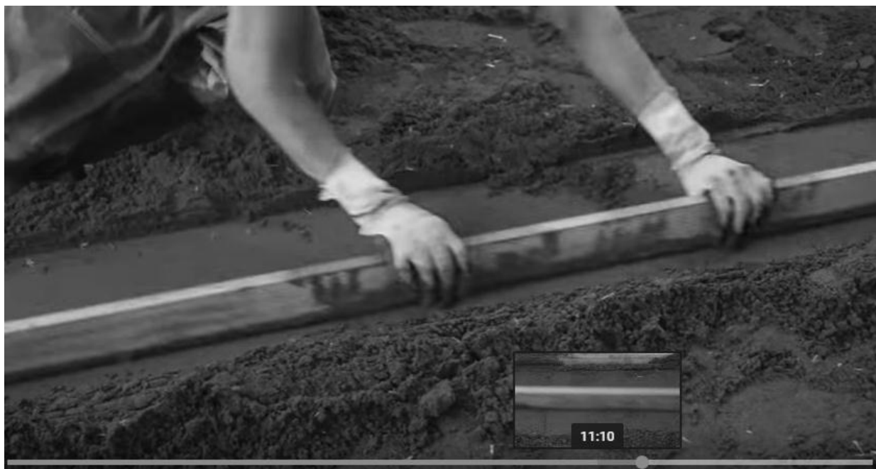
Рис. Е. 9. Ручне вирівнювання пісково-цементної суміші.
