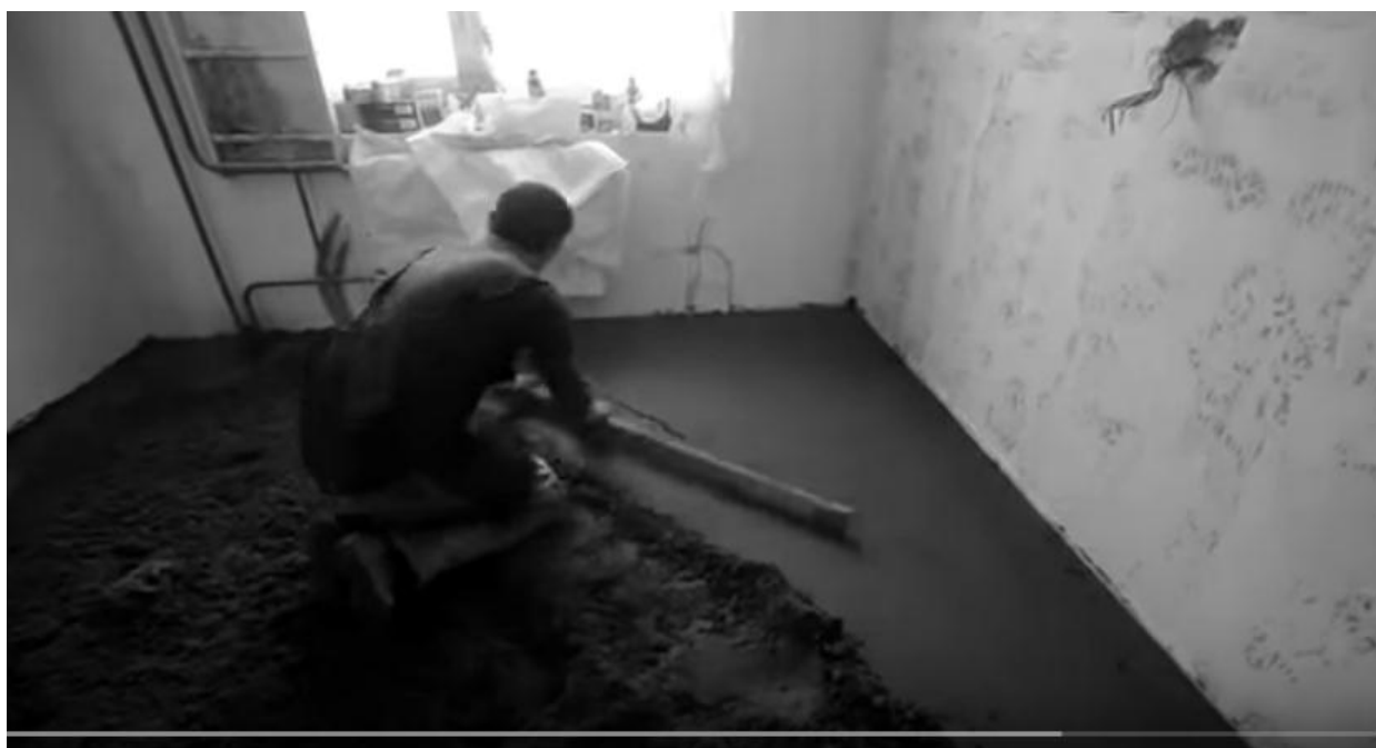
Рис. Е. 10. Ручне вирівнювання пісково-цементної суміші.
