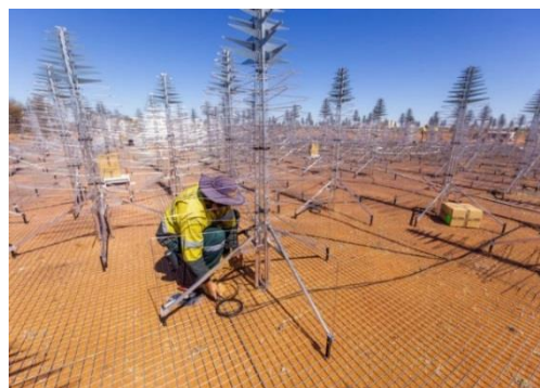
Рис. 13. Так виглядатиме антенне поле радіотелескопу SKA площею 1 км 2 з 130 тисяч окремих радіоантен
