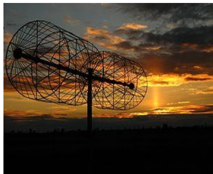
Рис. 10. Диполь антенної решітки радіотелескопу заввишки понад три метри кожний - елементи антени радіотелескопу УТР-2
