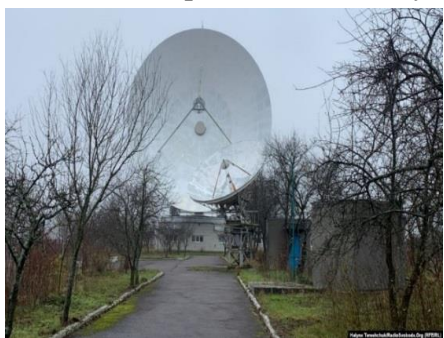
Рис. 21. Антена MARK-4B, на базі якої створений радіотелескоп РТ-32
